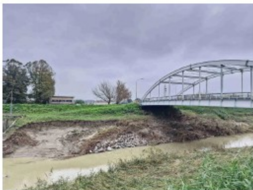
Inquadramento idraulica: Sponda e spalla in destra idraulica
