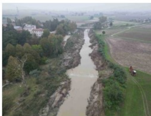
Inquadramento idraulica: Vista aerea dell'alveo e del ponte da monte verso valle
