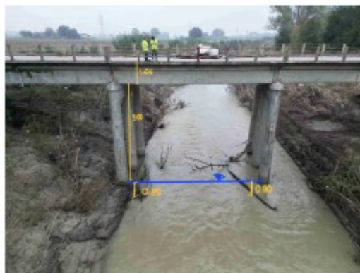
Annotazioni rischio idraulico: Rilievo del fondo alveo in corrispondenza dei basamenti delle pile
