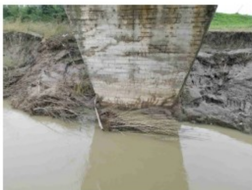
Inquadramento idraulica: Pila P1, vista da centro alveo
