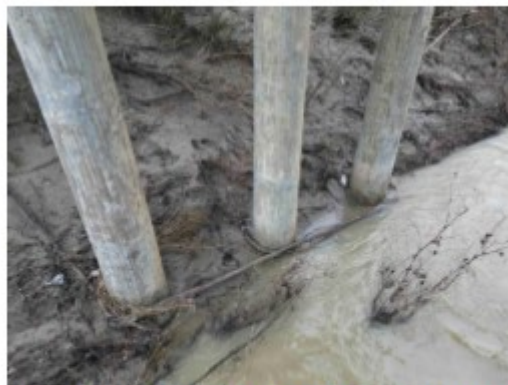
Inquadramento idraulica: Particolare del basamento della pila P3
