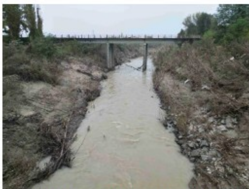
Inquadramento idraulica: Alveo e ponte, vista da monte
