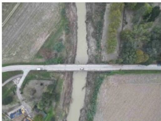
Inquadramento idraulica: Vista aerea planimetrica dell'alveo in corrispondenza del ponte
