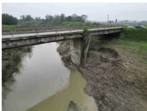
Inquadramento idraulica: Pila P1, vista da valle
