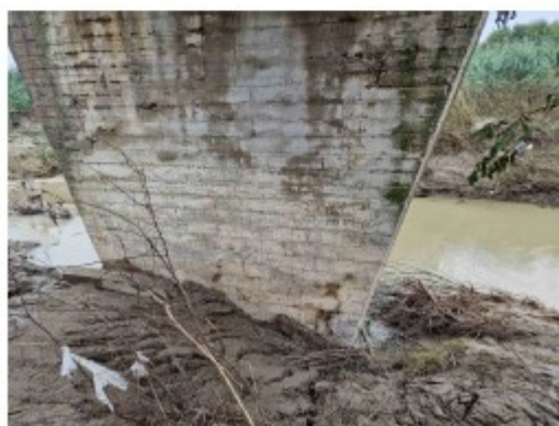
Inquadramento idraulica: Pila P1, vista da sponda sinistra
