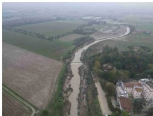
Inquadramento idraulica: Vista aerea dell'alveo a monte dopo l'evento alluvionale
