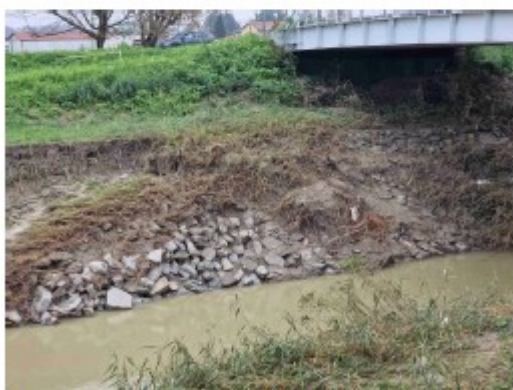
Opere di protezione spondale: Scogliera a protezione della sponda in corrispondenza delle spalle
