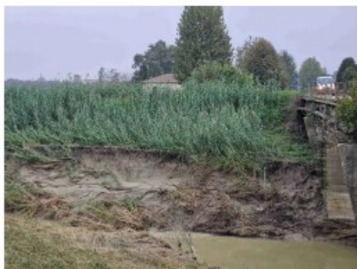
Divagazione planimetrica dell'alveo: Erosione spondale più rilevante a valle della pila P2 in destra idraulica
