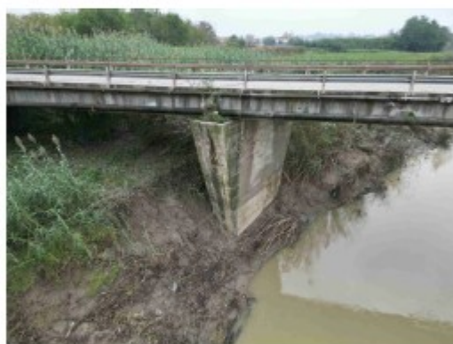
Inquadramento idraulica: Pila P2, vista da valle
