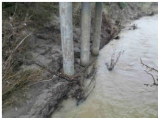
Inquadramento idraulica: Basamento della pila P3, vista da monte
