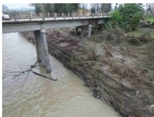
Inquadramento idraulica: Sponda in destra idraulica, vista da monte
