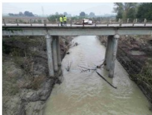
Inquadramento idraulica: Alveo inciso sotto al ponte, vista da monte
