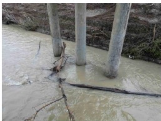
Inquadramento idraulica: Basamento della pila P2 sommerso (fondo alveo misurato con sonda e stabile)
