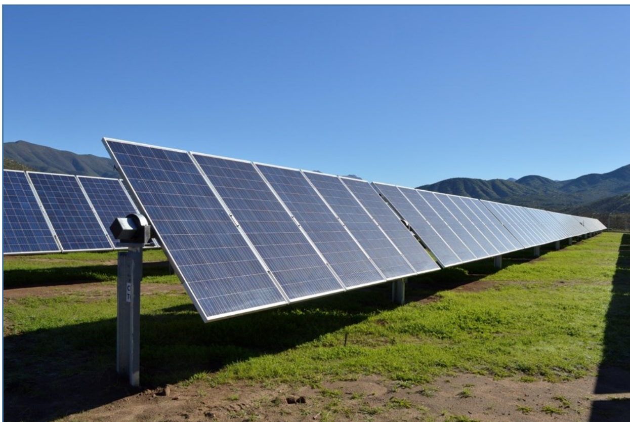
FIGURA 10 – INSTALLAZIONE SU INSEGUITORE MONO ASSIALE CON SINGOLO MODULO
